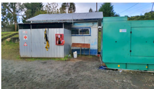
Estanque de Reserva y Grupo electrógeno (Izquierda) y válvula de salida estanque de reserva (Derecha)
